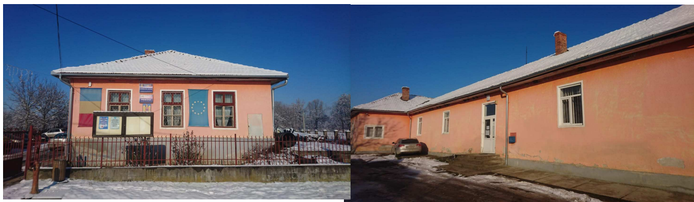
Figura 24. Sediul primăriei comunei Valcău de Jos
